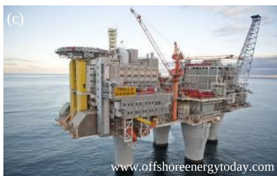
Abbildung 8-1: Alternativer Einsatz von Beton: Betonschiff Capella (a), Flugkörper mit Spannbetonflügeln aus (Brocard & Bruner 1953) (b), Gasplattform Sea Troll A (c), Errichtung eines Betonturms für eine Windenergieanlage (d)
