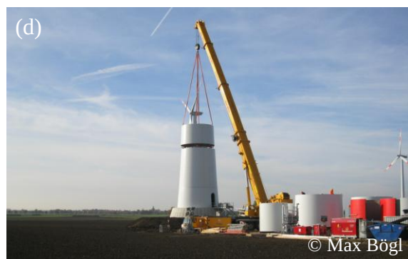
Abbildung 8-1: Alternativer Einsatz von Beton: Betonschiff Capella (a), Flugkörper mit Spannbetonflügeln aus (Brocard & Bruner 1953) (b), Gasplattform Sea Troll A (c), Errichtung eines Betonturms für eine Windenergieanlage (d)
