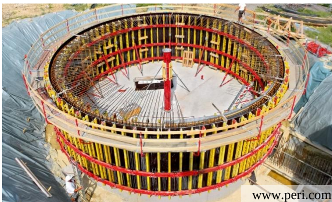
Abbildung 8-15: Konventionelle Rundschalung zur Herstellung des Skirts
