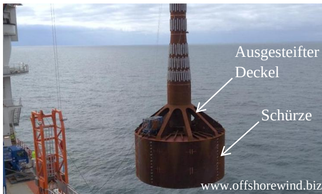
Abbildung 8-10: Stahlbucket eines Messmastes des Windparks Dogger Bank
