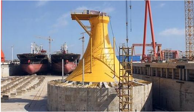
Abbildung 8-2: Monopod Suction Bucket in Spannbetonbauweise aus (Hongyan et. al. 2013)
