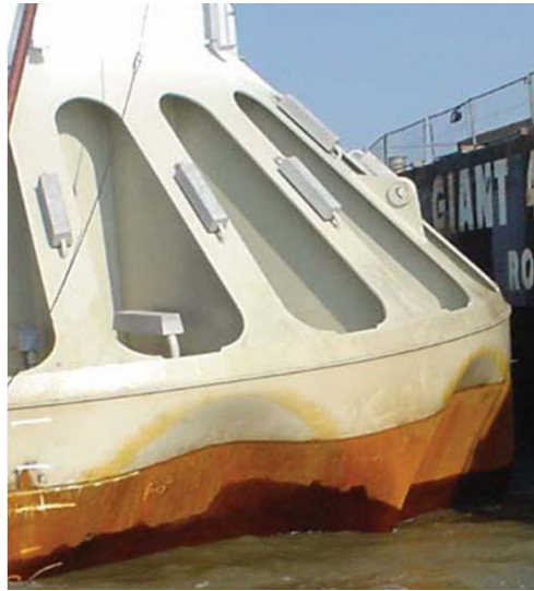
Abbildung 7-3: Verbeulung des Buckets der Firma Enercon vor Hooksiel (Madsen, Andersen, & Ibsen, 2012)
