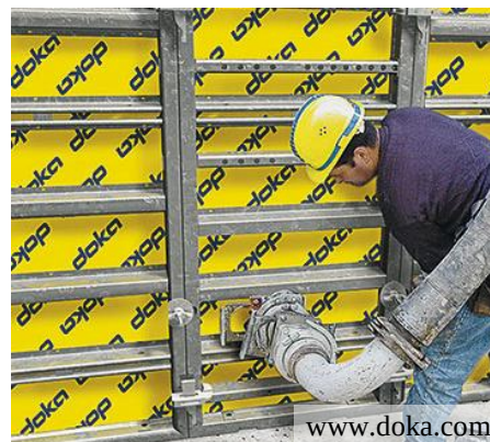
Abbildung 8-16: Einpumpen von selbstverdichtendem Beton
