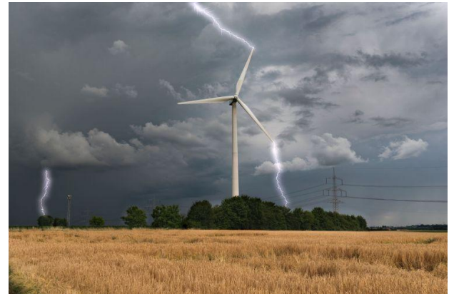
Abbildung 1: Blitzeinschlag in WEA [1]
