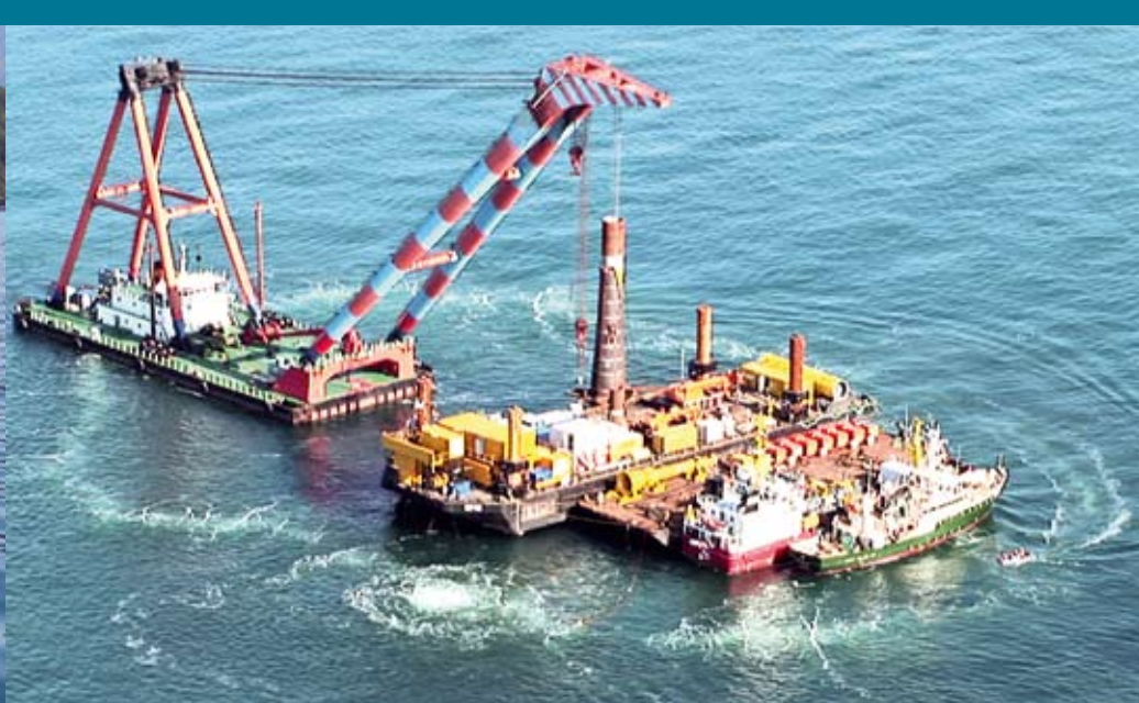
Bild 1: Blasenschleier beim Bau der Finow 3 . Foto: Forschungs- und Entwicklungszentrum FH Kiel GmbH
