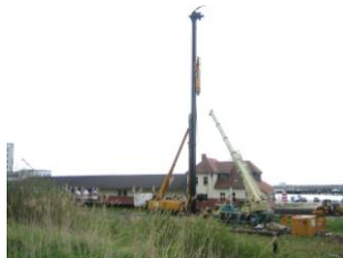
Einbringen der Fundamentpfähle der Fußgängerbrücke Sassnitz
