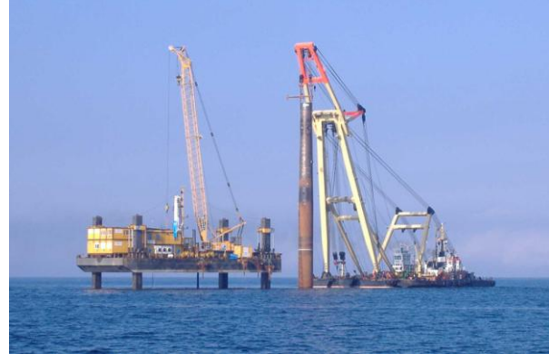
Bau der Forschungsplattform FINO II, Ostsee
