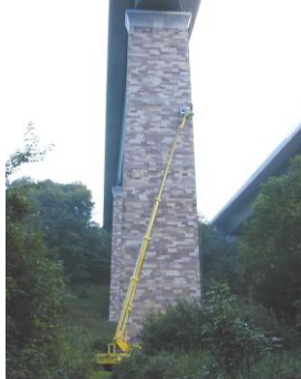
Werratal-Brücke der DB, Beurteilung der Schwingungseinwirkung aus dem Zugverkehr
