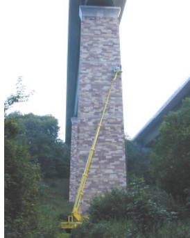
Werratal-Brücke der DB, Beurteilung der Schwingungseinwirkung aus dem Zugverkehr
