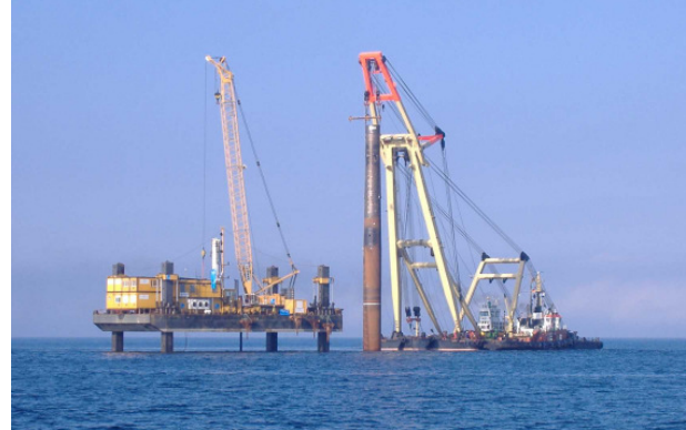
Bau der Forschungsplattform FINO II, Ostsee
