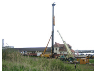
Einbringen der Fundamentpfähle der Fußgängerbrücke Sassnitz
