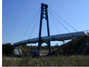
Schwingungstechnische Untersuchung der GFK-Brücke in Schwerin durch Messung und Simulation
